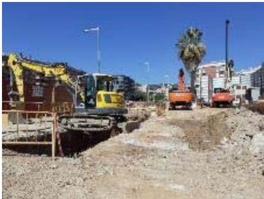
Execució de biga de lligat i pantalles 1a fase del vestíbul
