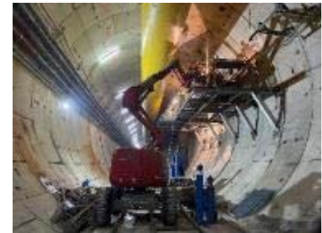
Muntatge booster cinta transportadora
