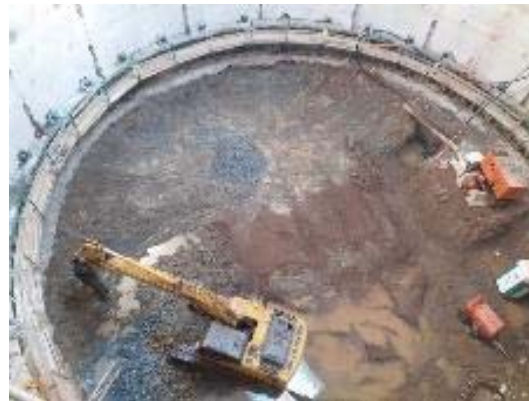
Excavació nivell 7 del pou
