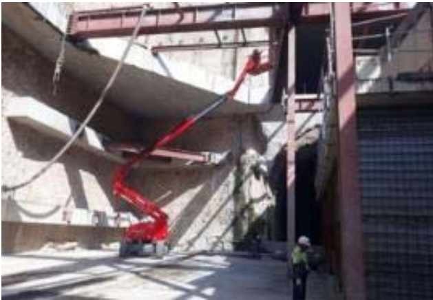
Retirada estructures metàl·liques al macropou
