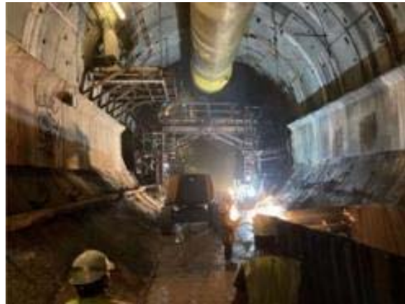
Retirada encofrats mènsoles de recolzament llosa intermitja de la fase anterior
