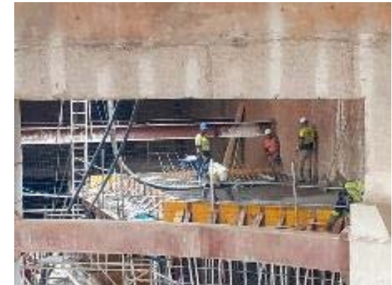
Execució de replans i trams d'escala de la SE
