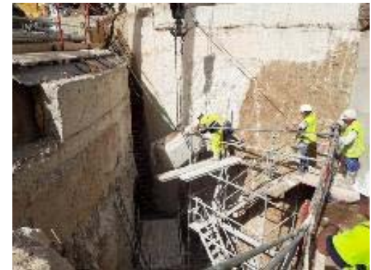
Obertura de la finestra de connexió del vestíbul amb el pou
