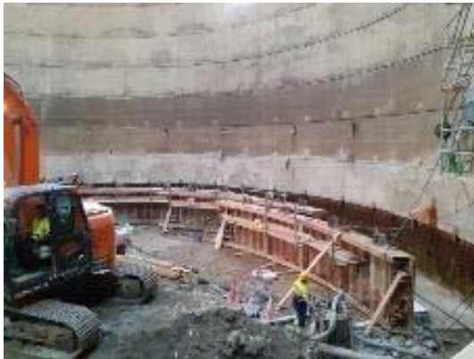
Muntatge de l'encofrat de l'anell 9
