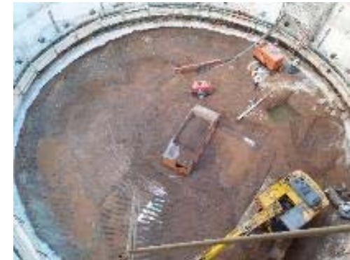
Excavació del pou
