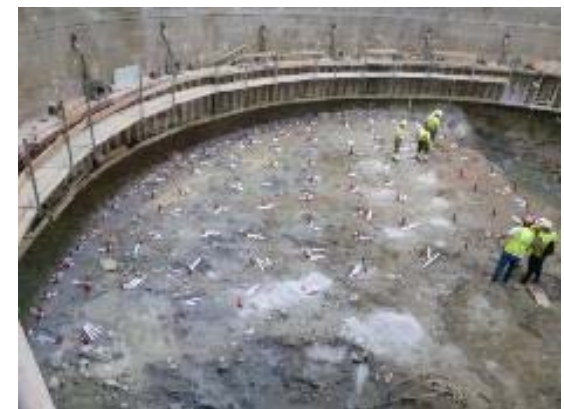
Treballs de perforació per execució de les voladures de l'anell 9
