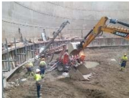
Treballs de perforació per execució de les voladures de l'anell 9
