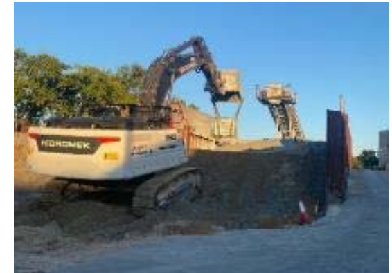
Material excavat acumulat al fossar de descàrrega
