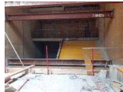
Execució lloses d'escala sortida d'emergència
