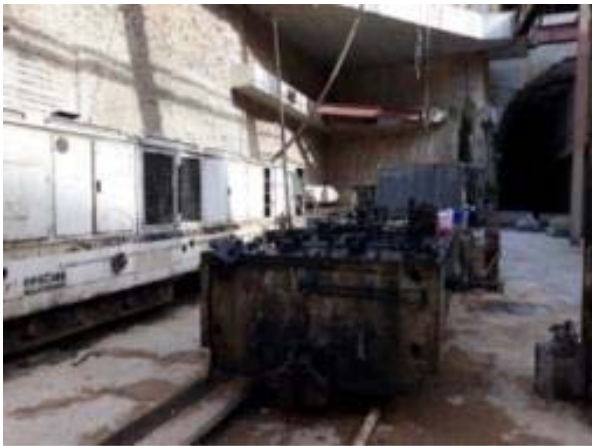
Retirada de trens i locomotores amb abassegament provisional en superfície al Macropou per posterior gestió.
