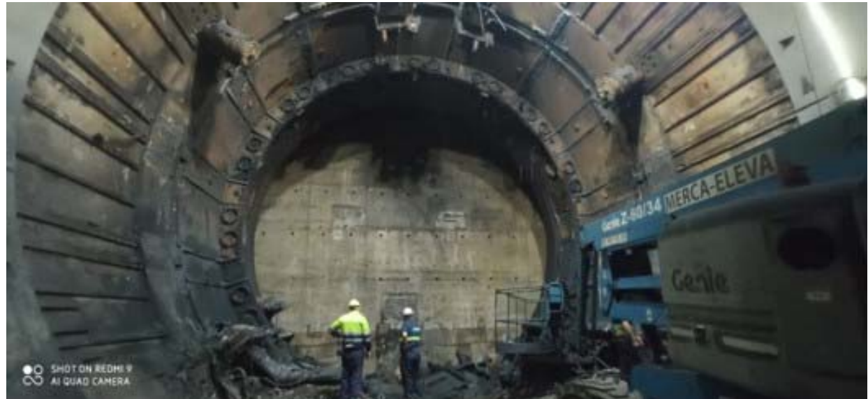
Estat general de desmuntatge de la tuneladora
