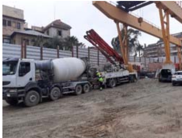
Formigonat de l'anell 11
