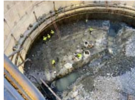
Preparatius de la microvoladura del 14/2/2023
