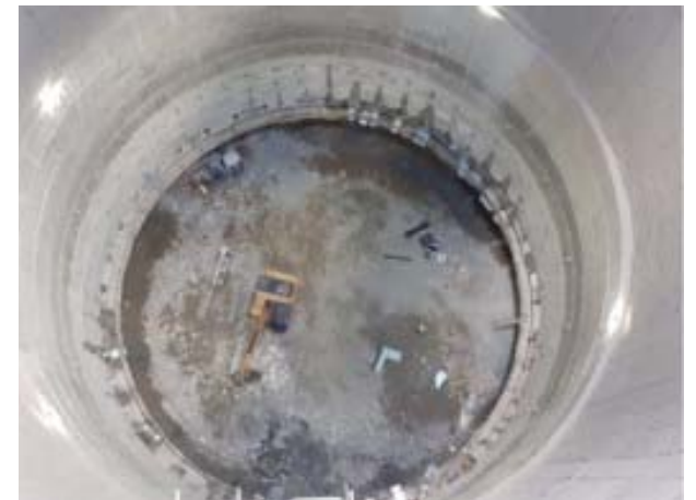
Vista general del pou
